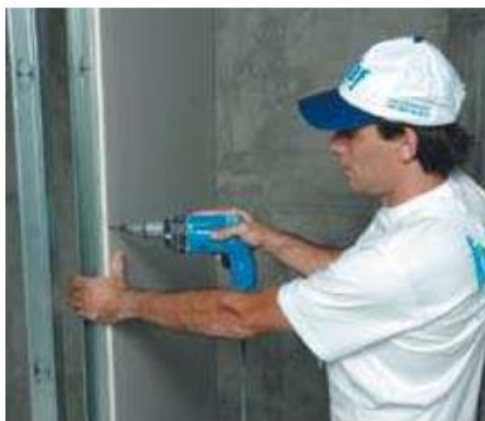
Fig. 3.8 Fechamento de um dos lados da parede de drywall
