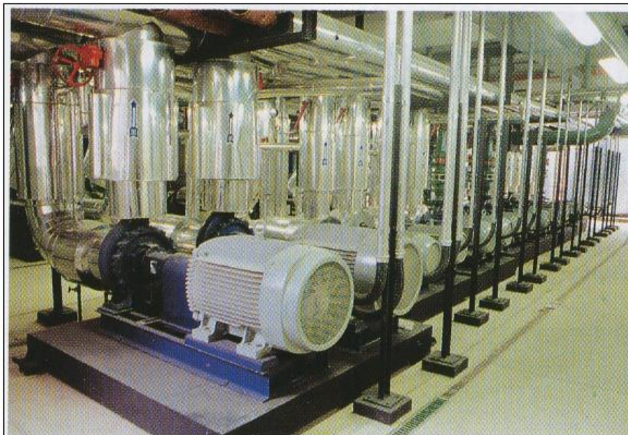
Figura 2.4: Central de ar condicionado com termo acumulação da bolsa de mercadorias e futuros, centro de São Paulo. Fonte: Croitor, 2008
