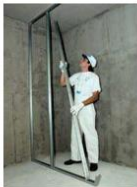
Fig. 3.6 Colocação de montantes em guias de drywall
