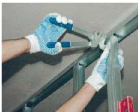
Figs. 3.7 Fixação dos montantes nas guias
