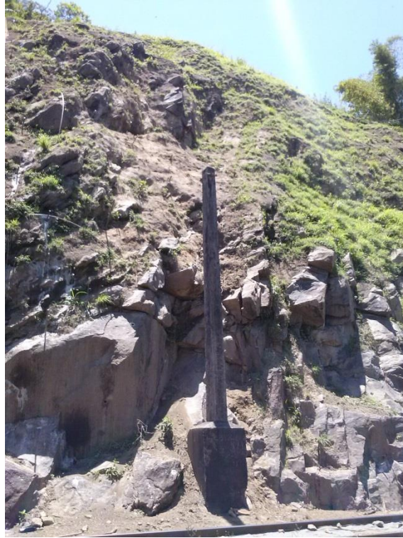
Figura 17 - Fase inicial da obra
