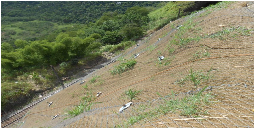
Figura 18 - Fase atual da obra
