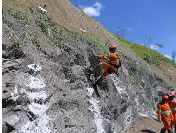
Figura 20 - Conferência de torque
