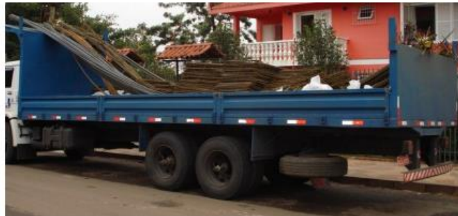
Figura 13 - Transporte do aço cortado e dobrado.
